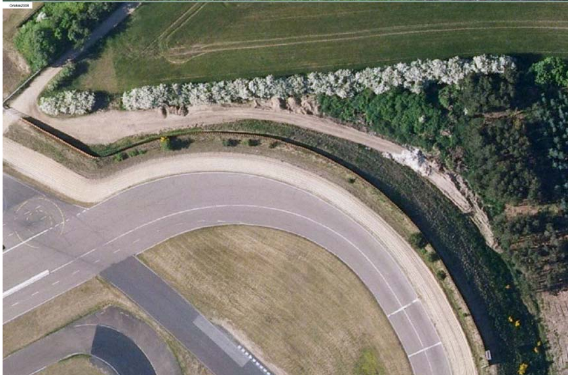
2008 – det ses tydeligt at der deponeres i området.
